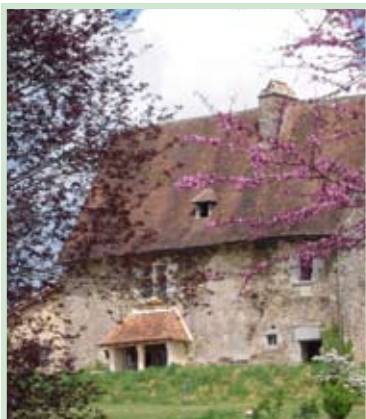
Saint Paul La Roche, maison templière © Communauté de Commune Pays de Jumilhac
