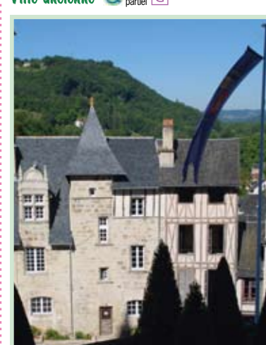
Terrasson-Lavilledieu, Maison Bouquier © OT de Terrasson-Lavilledieu
