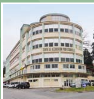
Clairvivre, anciens magasins généraux, © CAUE 24
